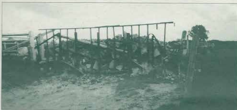
Sentier 75 - face au resto Tagalop (Chemin de Bas-Ransbeck) fermé par un mur de gravats solidement arrimé.
