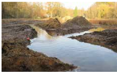
Mise sous eau finale (source : Commune de Lasne)
