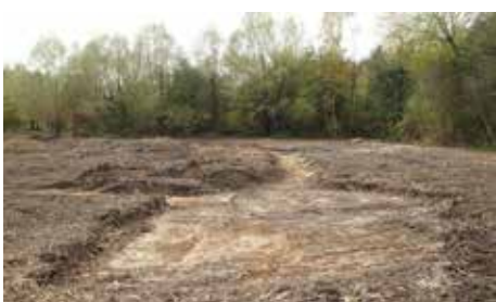
Étrépage, raclage et mise en tas
